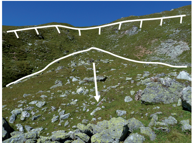
E. Ausbruchsnische einer Felsgleitung in Grünschiefern und Quarziten der Matreier Zone. Obwohl die Gleitmasse nach kurzem Transport im Abrissbereich verblieben ist, liegt nur mehr ein komponentengestütztes (Steine, Blöcke) Lockermaterial vor (lithogenetische Sedimentneubildung).
